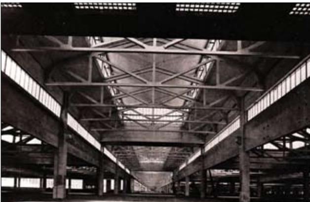
Fig. 5: Uso del vetrocemento nella copertura di un edificio dello Stabilimento Fiat a Mirafiori, Torino (da L'industria del vetro in Italia 1940).
